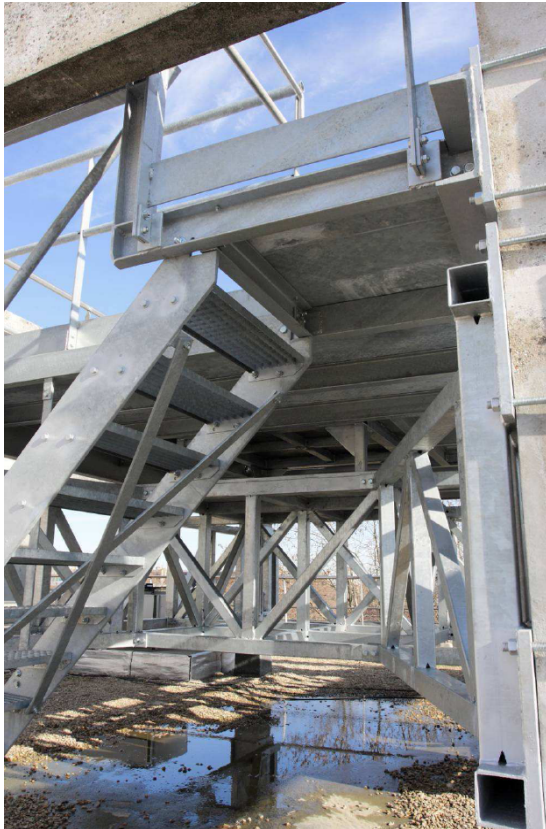
Structure pour l'installation de FTLRS a l'Observatoire de paris
